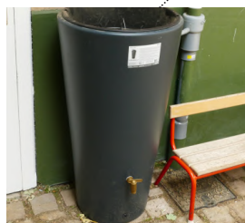
Cuve de récupération des eaux
