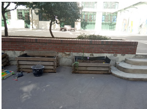
Différence de niveau depuis la cour basse
