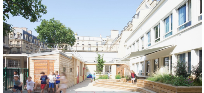
Zone de copeaux des maternelles sur dalle, surélevée pour drainer l'eau vers la zone plantée en contrebas | © Théo Ménivard/ CAUE de Paris
