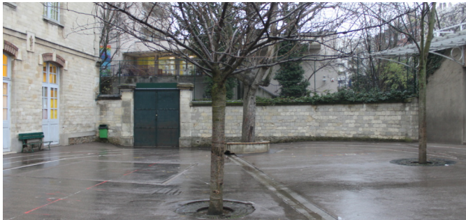
La cour avant les travaux | © CAUE de Paris
