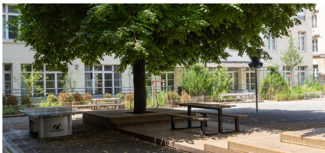
Cour élémentaire. Plateformes bois protégeant le système racinaire des arbres existants. Assises, gradins pour l'école dehors | © Ville de Bordeaux - T.Sanson
