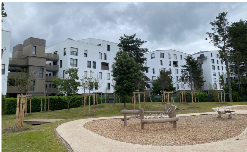
Vue d'ensemble de la cour | © Ville de Bordeaux
