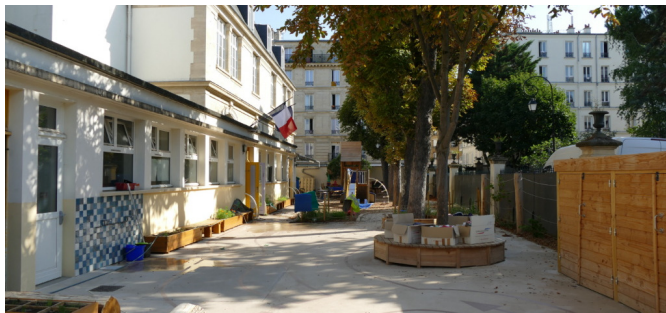
Vue d'ensemble depuis l'entrée | © CAUE de Paris
