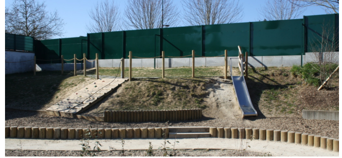
Aménagement du talus avec une structure d'escalade et un toboggan | © caue95
