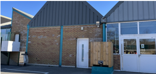
Récupérateur d'eau | © caue95
