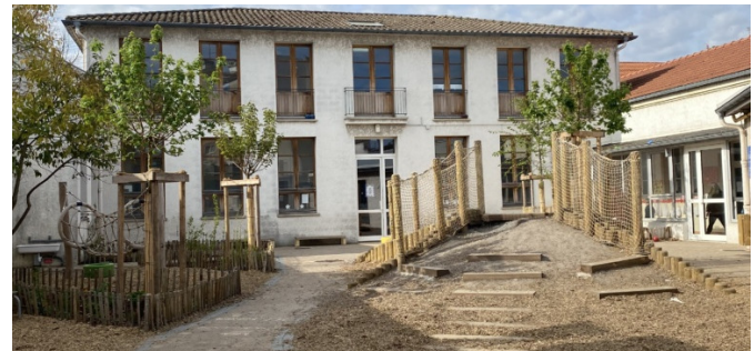
Vue de la cour (depuis le fond) | © Ville de Bordeaux
