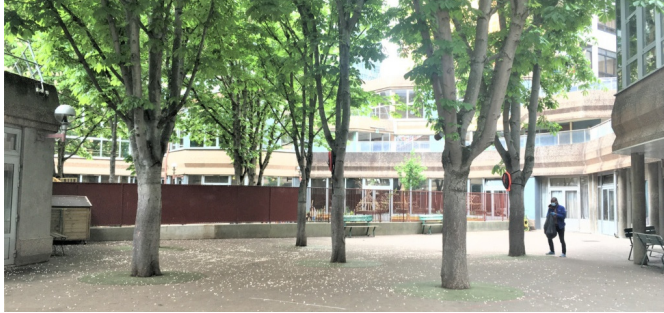
Vue de la cour avant travaux | © CAUE de Paris
