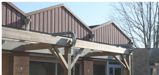
Aménagement d'une pergola, support de la déconnexion des gouttières permettant d'acheminer l'eau de la toiture jusqu'à la noue végétalisée. Une chaîne de pluie permet d'acheminer l'eau doucement jusqu'à la noue. | © Violette Salin
