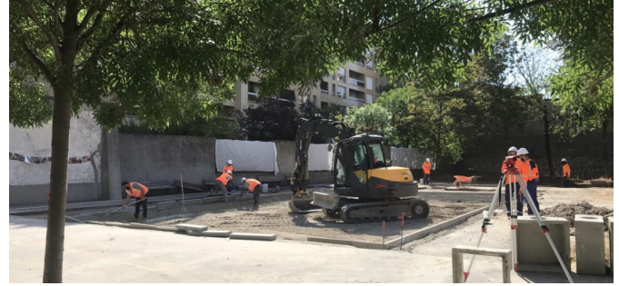
Mise en œuvre des bordures - Juillet 2022 | © CAUE de Paris
