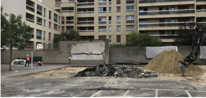
Décroutage de l'enrobé - Juillet 2022 | © CAUE de Paris
