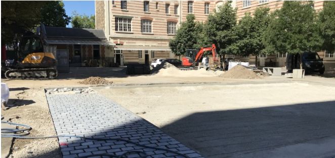
Mise en œuvre des pavés - Aout 2022 | © CAUE de Paris
