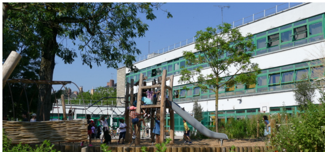
Structure de jeu dans l'espace de copeaux hors-sol | © CAUE de Paris
